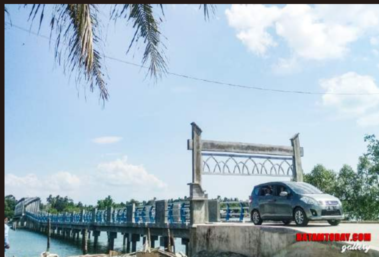
Jembatan Desa Pengujan
