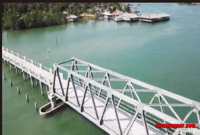
Tampak dari atas Jembatan Desa Pengujan
