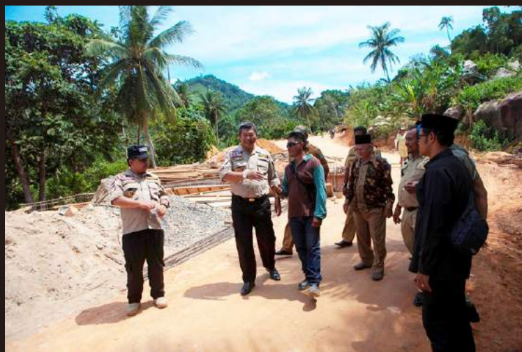
Bupati Anambas berbincang dengan kontraktor pelaksana pembangunan jalan di Palmatok
